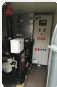
**H**auseinspeisestelle mit Netzumschaltung. Vorsicherung, Einspeisesteckdose und vorbereitetem Einspeisekabel gem. EN 60947.
